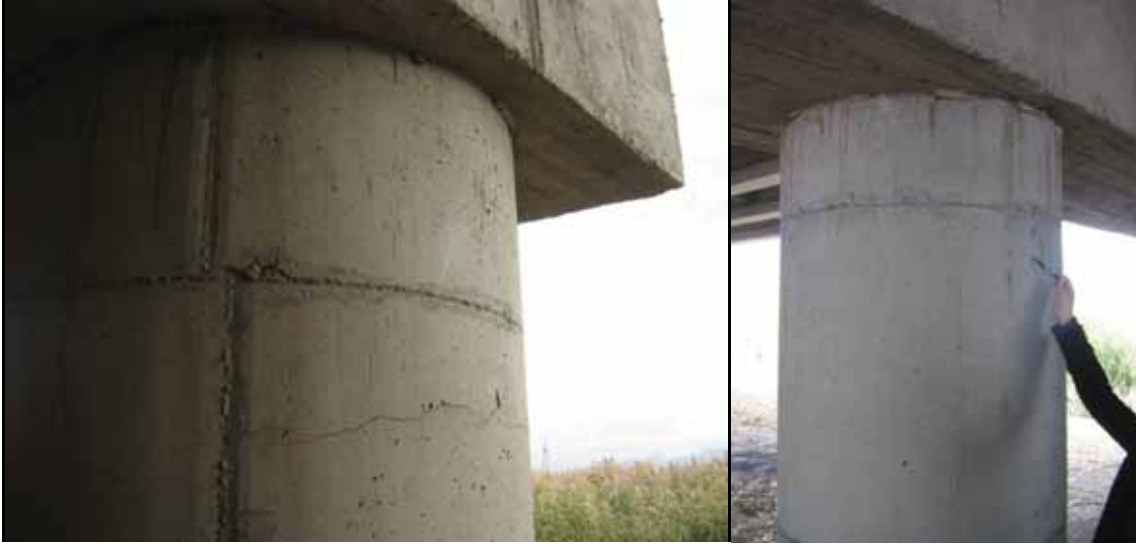
Şekil 4.3. Deprem sonrası çatlamış köprü kolonları.
