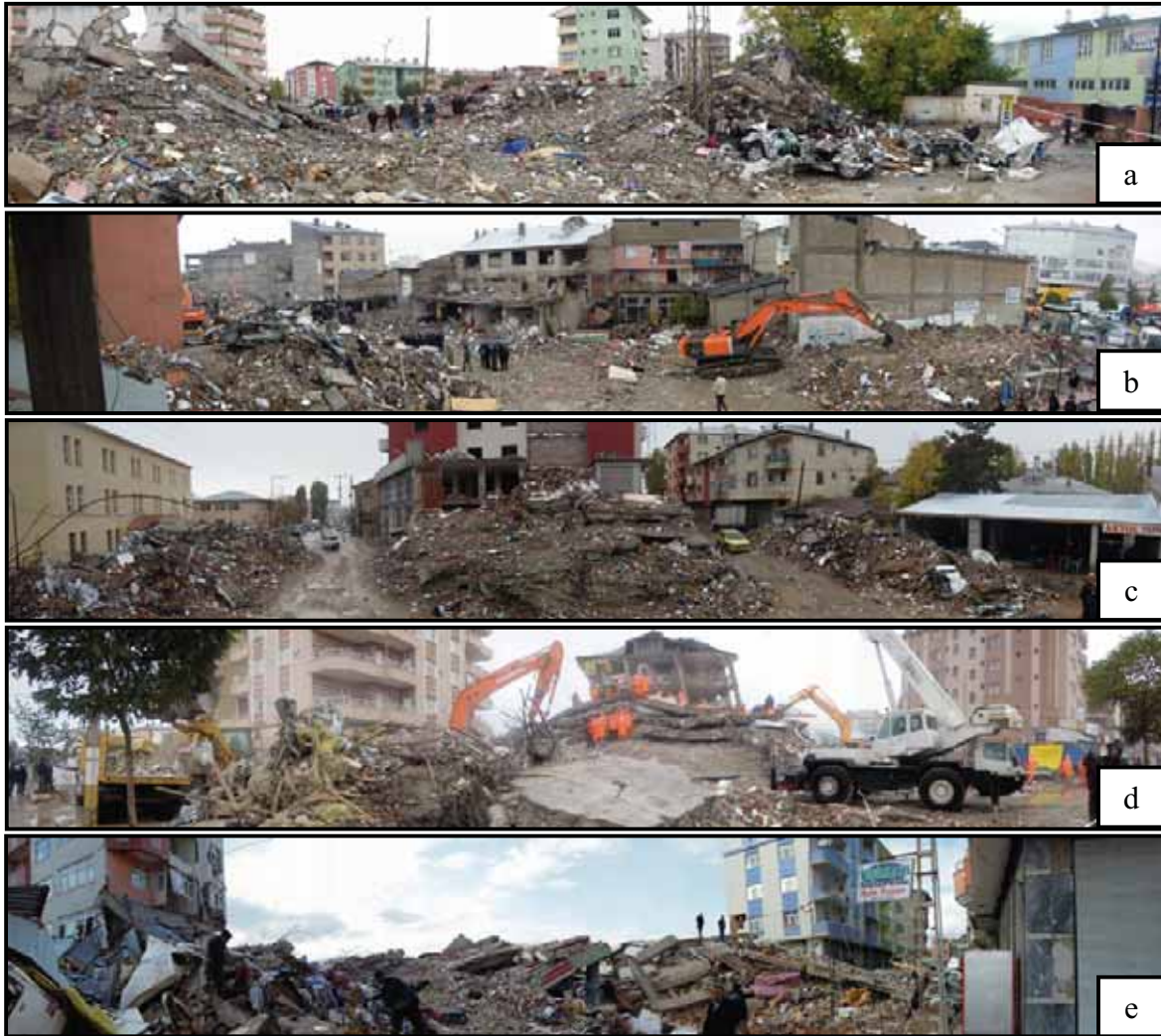
Şekil 3.1. Tamamen göçüp enkaz haline gelen binalar.
