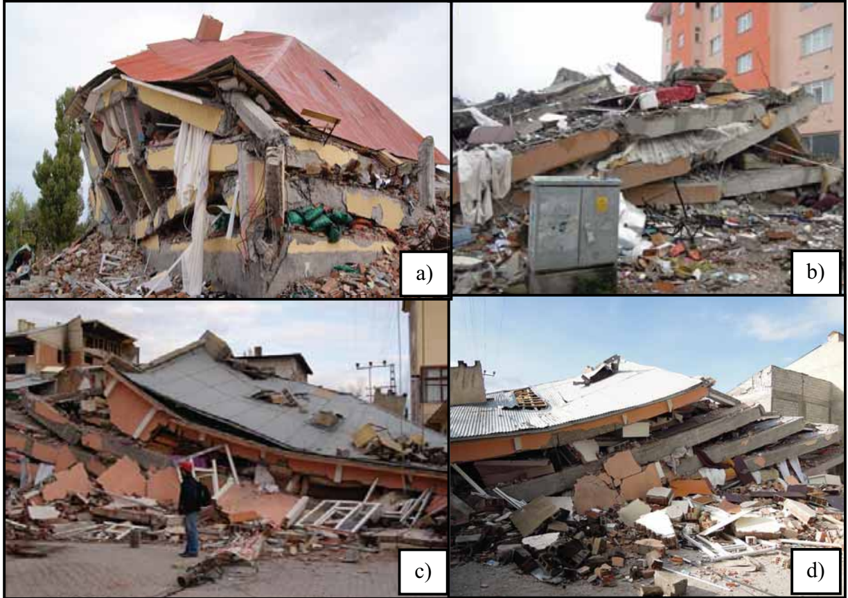
Şekil 3.2. Katların üst üste yığılması sonucu yıkılan binalar.
