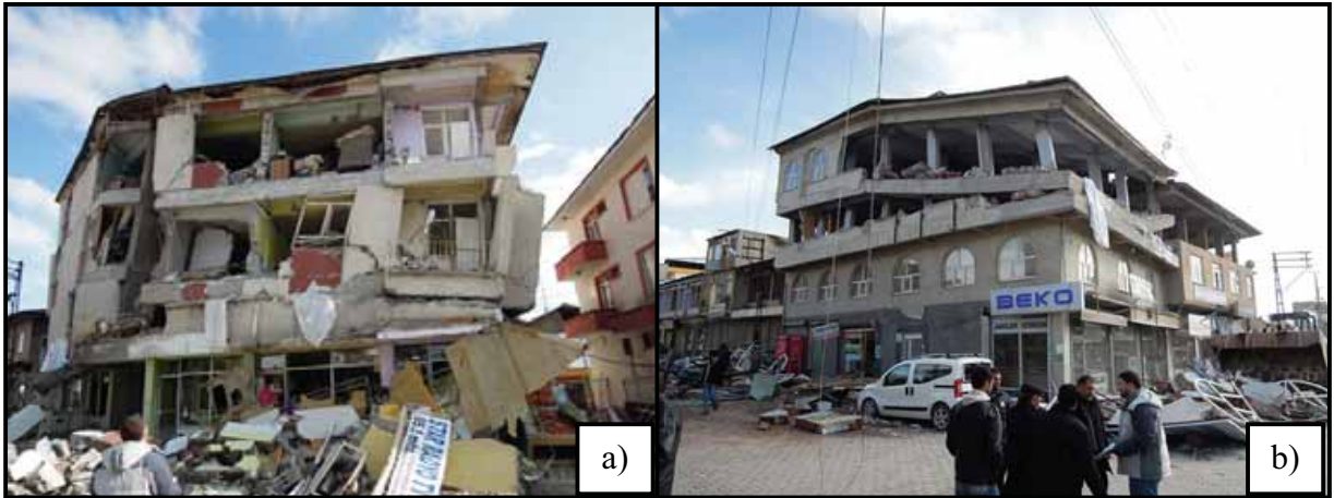
Şekil 3.4. Zayıf kat üzerine yıkılan binalar.
