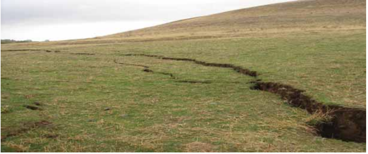
Şekil 2.9. Van-Erciş Karayolu şev kayması taç bölgesindeki çatlaklar.
