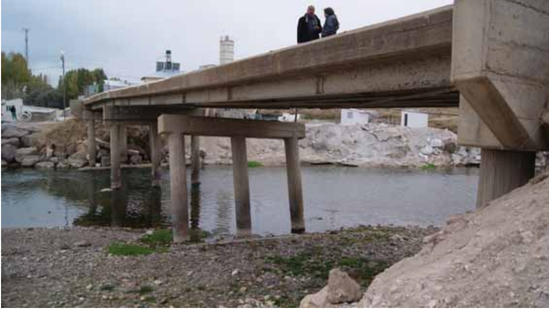
Şelik 4.4. Birkaç sene önce sel afetinden dolayı ayaklarının biri eğilen kompozit köprünün deprem sonrası genel görüntüsü.
