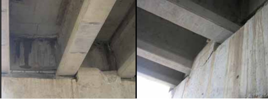
Şekil 4.2. Hasar görmüş deprem takozları.
