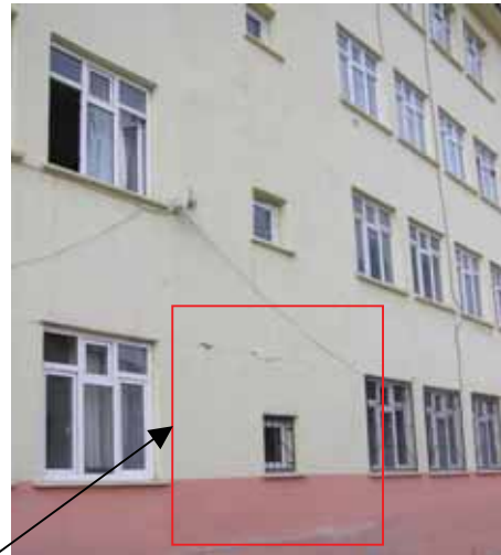
Güçlendirme için ilave edilen Perdede Arayüz Çatlakları
