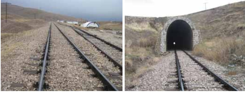
Şekil 4.5. Hasar görmemiş demiryolu hattı ve demiryolu tüneli.
