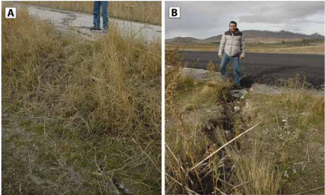
Figure 1.6. Yollarda meydana gelen ikincil deformasyonlar. (a) Van-Topaktaş yolu üzeri, hapishane yanı, (b) Van-Erciş yolu TOKİ konutları yanı.
