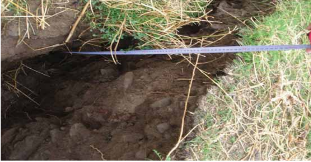
Şekil 2.11. Van-Erciş Karayolu şev kayması çatlakları.
