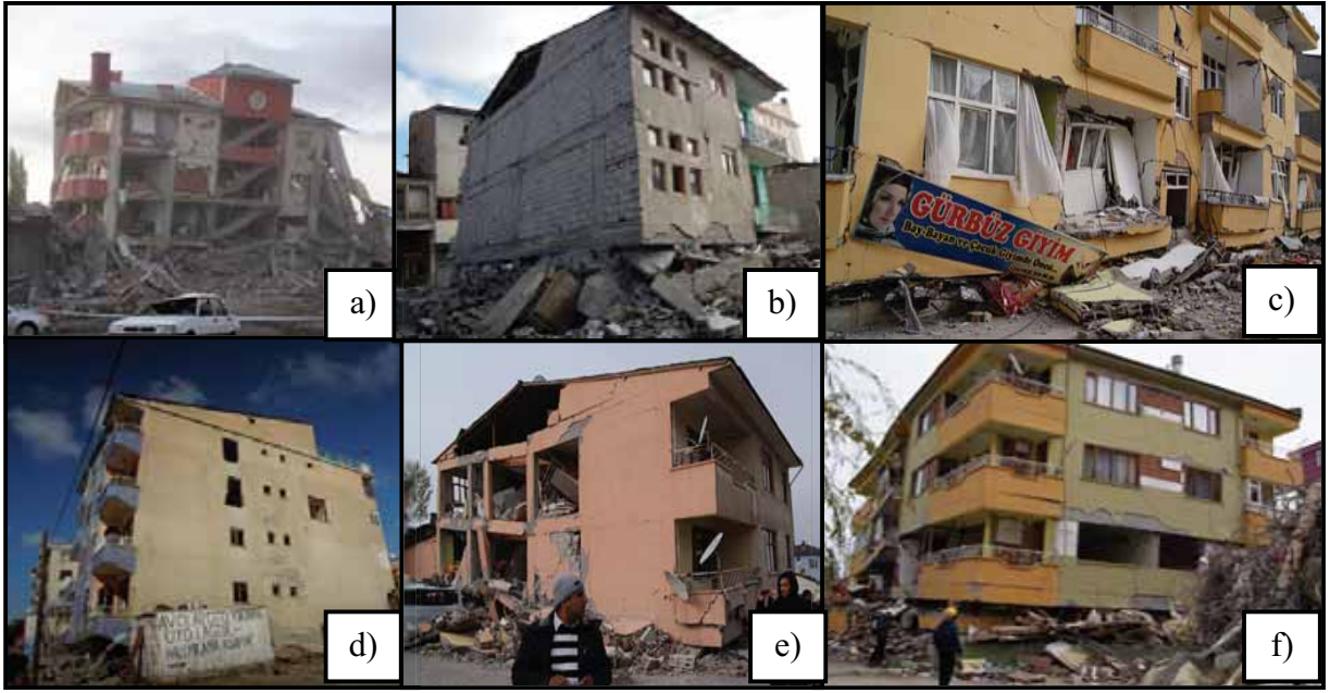
Şekil 3.3. Yumuşak kat düzensizliğinden dolayı yıkılan binalar.
