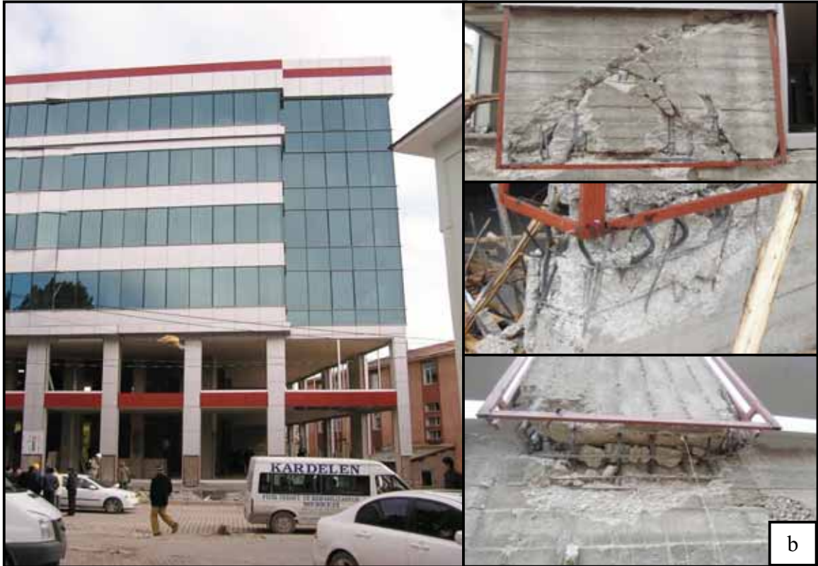
Şekil 3.5. Zemin kat kolon uç bölgelerinde plastik mafsallar oluşan ağır hasarlı binalar.
