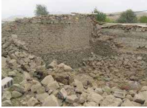
Şekil 3.27. Taşıyıcı duvarlarında farklı malzemeler (kerpiç, taş, briket) kullanılmış ve Van depremi esnasında yıkılmış bir yığma bina.
