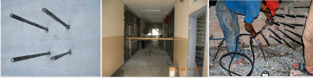
GRAFİK 21 YAPILARIN VE ALTYAPI SİSTEMLERİNİN GÜVENLİ HALE GETİRİLMESİ - KOLON, KİRİŞ VE DUVAR DETAY GÜÇLENDİRME ÇALIŞMALARI
