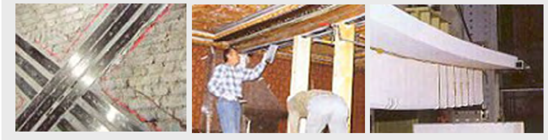
GRAFİK 21 YAPILARIN VE ALTYAPI SİSTEMLERİNİN GÜVENLİ HALE GETİRİLMESİ - KOLON, KİRİŞ VE DUVAR DETAY GÜÇLENDİRME ÇALIŞMALARI
