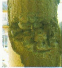
Resim 4: Yeni Mahalle caminin bir kolonunda hasar ve kullanılan agrega
