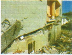
Resim 5: Bingöl depreminde Zemin katı göçen B+Z+ 3 katlı yapıda beton kalitesi
