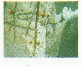
b) Sıva tabakası altındaki Taşıyıcı eleman
