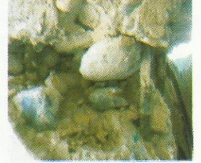
Resim 4: Yeni Mahalle caminin bir kolonunda hasar ve kullanılan agrega
