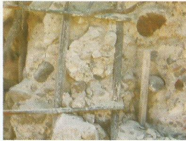
c) Nitelsiz Beton ve Yetersiz sargı donatısı
