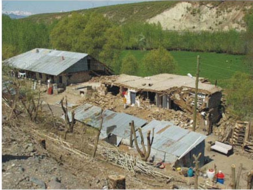
Foto 26. Kırsal yerleşmelerde (Beyaztoprak mahallesi) çamur harçla inşa edilmiş bir yapıda meydana gelmiş hasar örneği.
