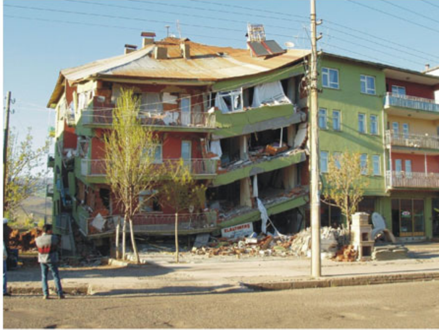
Foto 19-20. Bingöl kent merkezinde depremde giriş katı mukavemetsizliği nedeniyle ağır hasar görmüş bina örnekleri.
