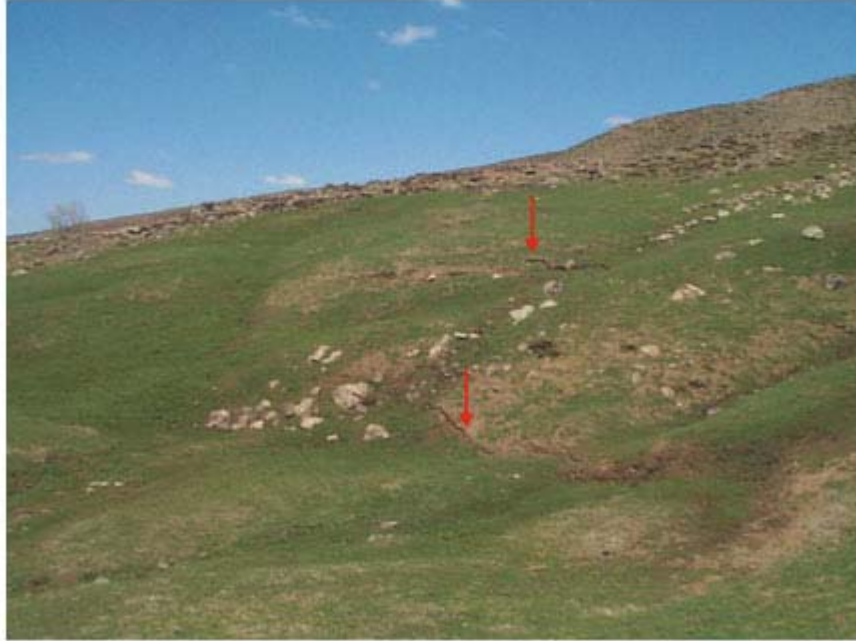
Foto 14. Bingöl-Göltepe köyü kuzeyinde eski bir heyelan topuğunda depremin tetiklemesiyle gelişmiş gerilme çatlakları.
