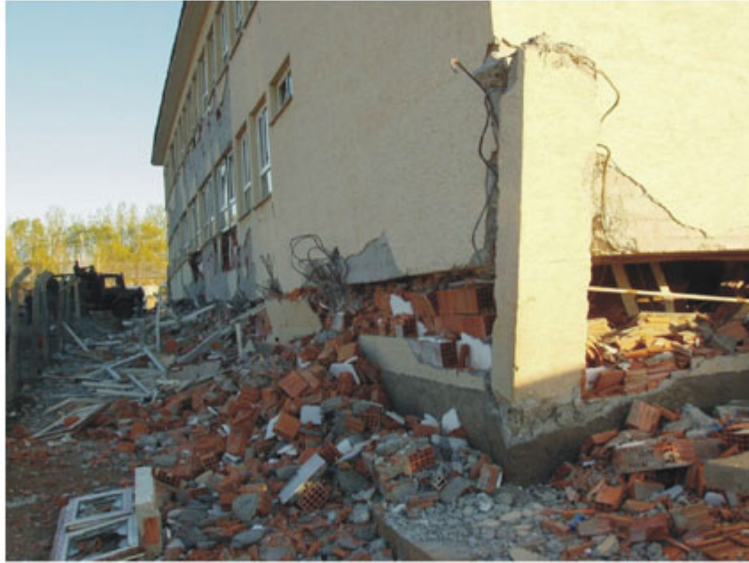
Foto 24. Kolonların kırılması sonucu 2. ve 3. katları giriş katı üzerine oturmuş olan Çeltiksuyu Yatılı İlköğretim Bölge Okulunun depremden sonraki görünümü.
