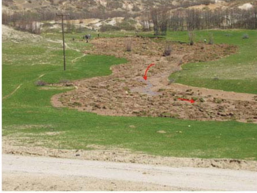
Foto 15. Oğuldere köyü kuzeyindeki Hano Çayırı mevkiinde depremde gelişmiş yanıl yayılma sonucu meydana gelen çamur akmasının genel görünümü. Çamur akması yaklaşık 750 m boyunca vadi tabanını kaplamıştır.
