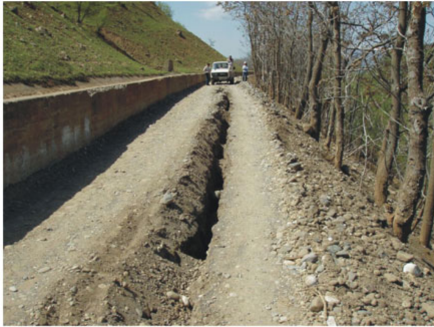
Foto 17-18. Göynük çayı vadisi batısında, Beyaztoprak mahallesi ile Ilıca beldesi arasındaki sulama kanalı boyunca yer alan toprak dolgu yolda depremde gelişmiş gerilme çatlağı niteliğindeki deformasyonlar.
