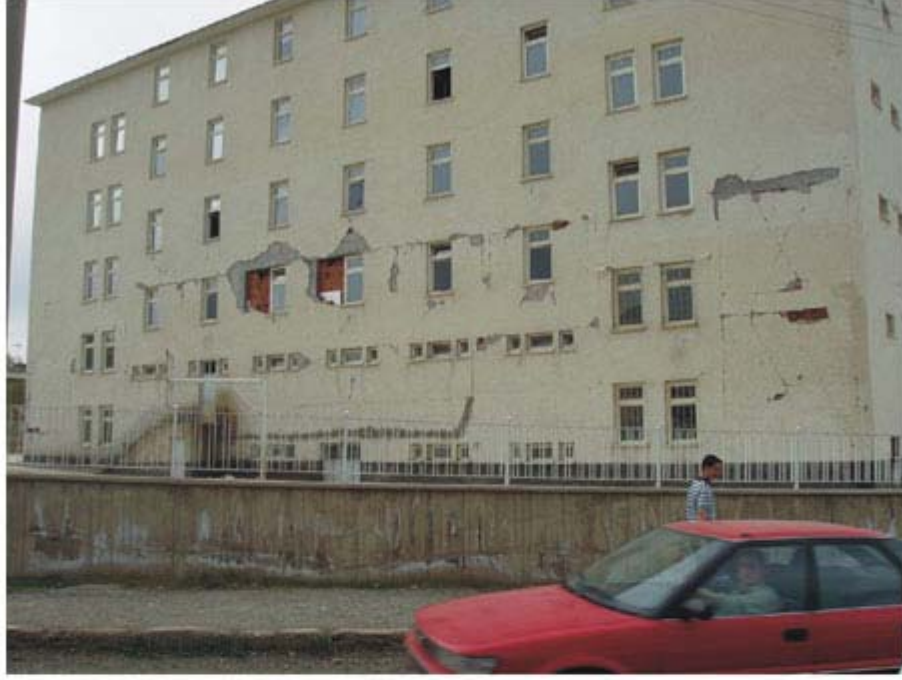
Foto 21. Bingöl Lisesi pansiyon binası duvarlarının dış yüzeyinde gelişmiş çatlamlar.
