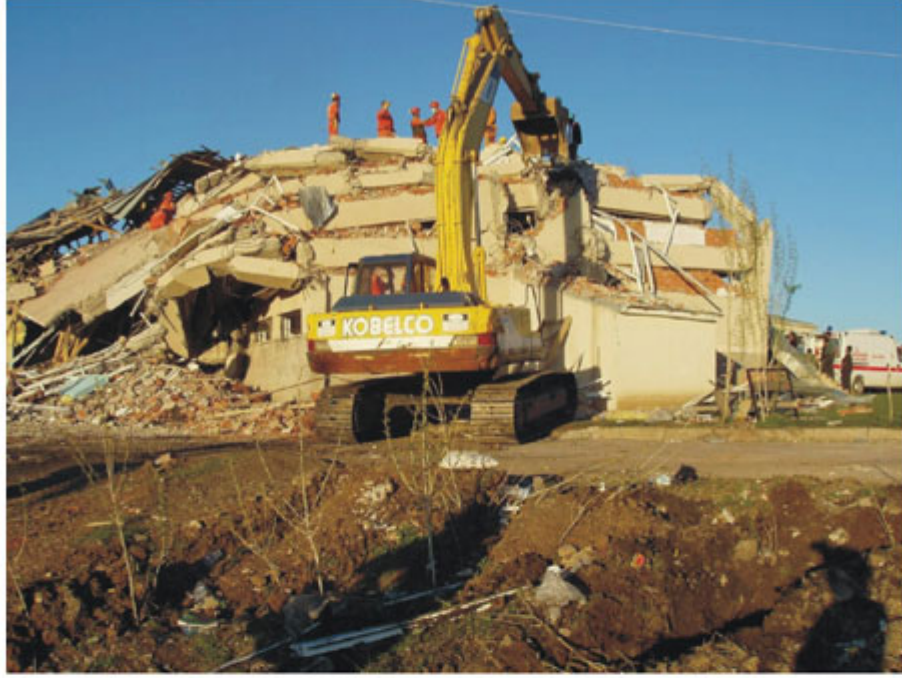
Foto 23. Depremde tamamen göçmüş ve 84 öğrenci ile 1 öğretmenin ölümüne yolaçmış olan Çeltiksuyu Yatılı İlköğretim Bölge Okulu pansiyon binasının görünümü.
