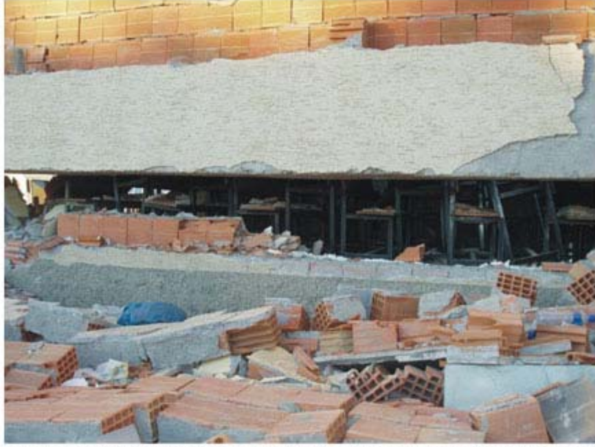
Foto 25. Foto 24'teki çöken giriş katının yakından görünümü. Binanın 2. ve 3. katları, çöken giriş katı dersanelerindeki demir profilden yapılmış sıraların üzerine oturmuştur.
