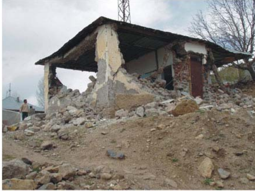
Foto 30. Heyelanlı bir zeminde kurulu olan Göltepe köyünde hasar görmüş bir yapı örneği.
