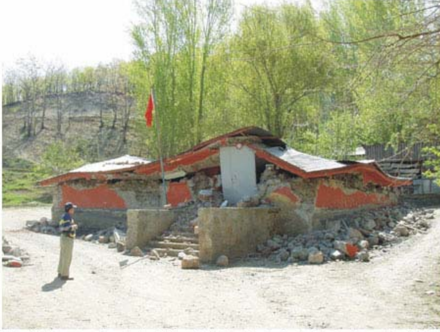
Foto 27. Beyaztoprak mahallesi (Bingöl) ilköğretim okulunda izlenen hasar. Bu okulun, 22.05.1971 Bingöl depreminden sonra yapılmış olmasına karşın Doğu Anadolu Fay zonu üzerine inşa edildiği dikkati çekmektedir.
